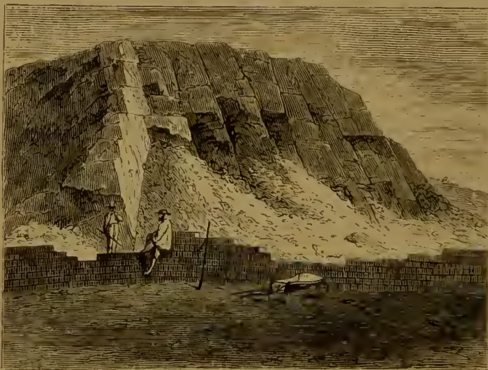
DEMOLISHING HUACA, LIMATAMBO.
