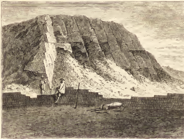
DEMOLISHING HUACA, LIMATAMBO.
