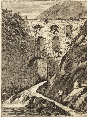
AQUEDUCT OVER THE RODADERO.
