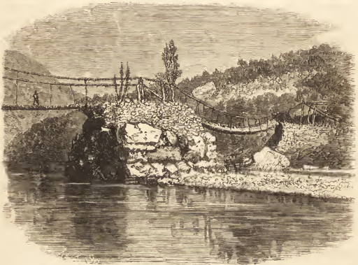
INCA BRIDGE, OLLANTAYTAMBO.
